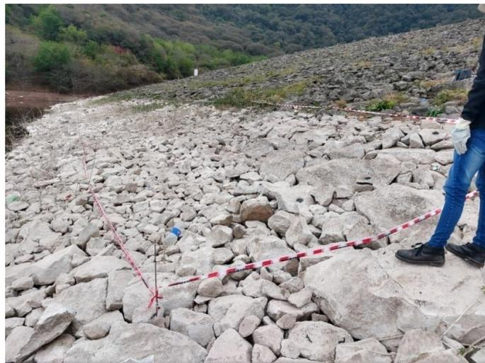
**Figura 1.** Rip-rap de la presa El Cadillal. Cuadrante N°1 del relevamiento de Wolman, septiembre de 2021, cota de embalse 606 msnm.
