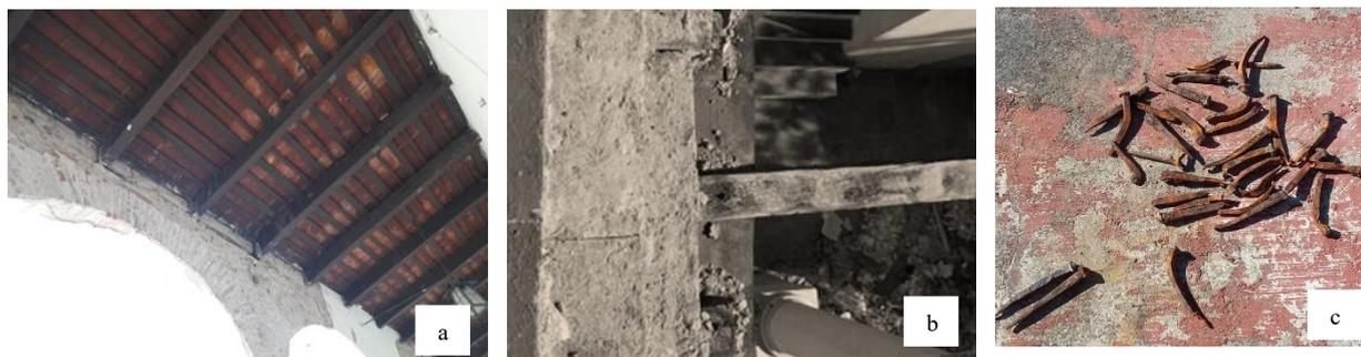
Figura 2. a) Vista del techo de la recova del Cabildo- b) Zona de los lugares de la recova de donde fueron extraídas las muestras de ladrillos- c) Clavos extraídos del techo de recova
